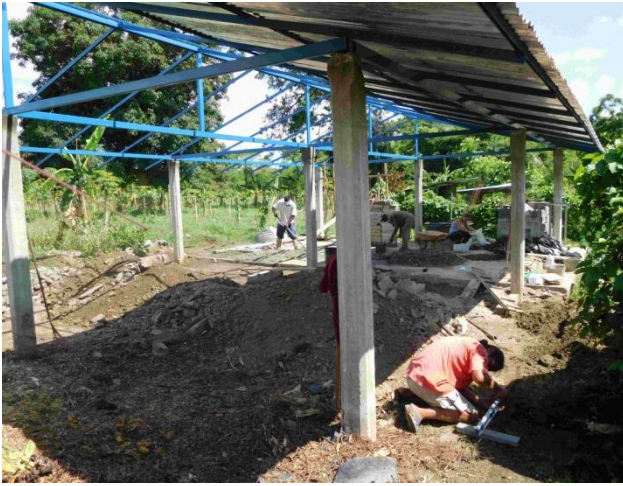
De verbouw de Bodem Ruimte is op gang
